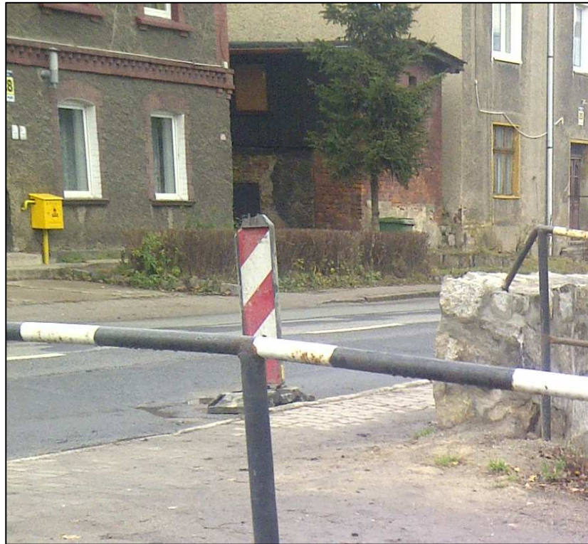
Fot. 4.1 Nawierzchnia na chodniku i zjeździe z mostu, przy drodze wojewódzkiej nr 381
