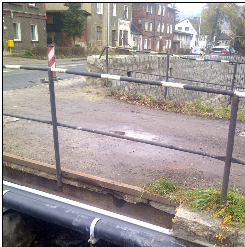
Fot. 4.2 Nawierzchnia na moście
