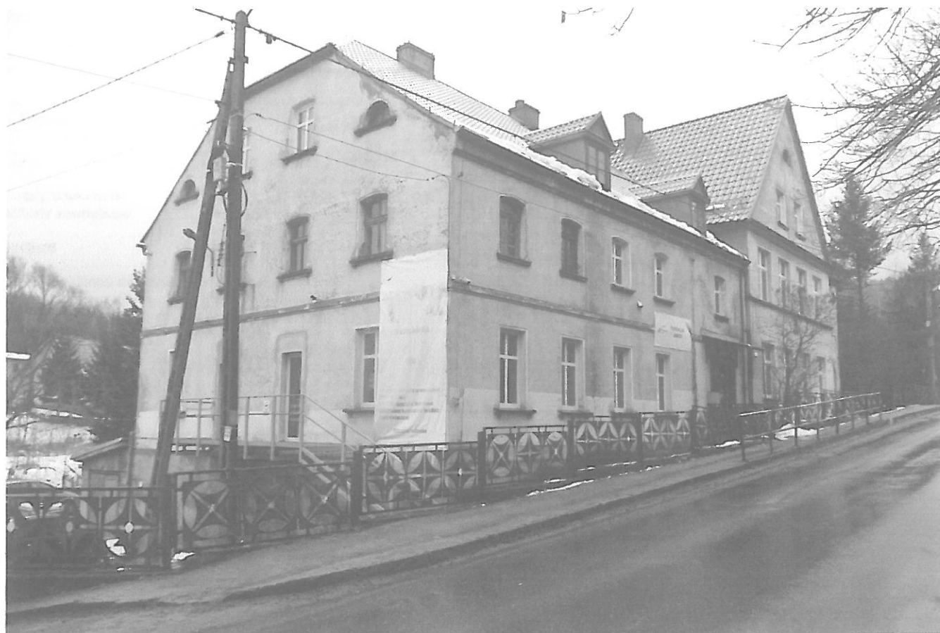
widok ogólny budynku
